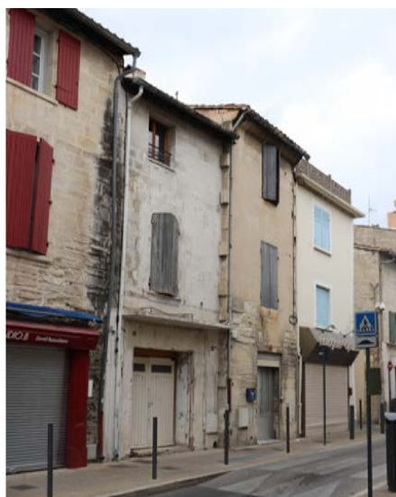
Certains secteurs du centre ancien de Beaucaire sont fortement concernés par la vacance de logements (photo : rue Nationale)
