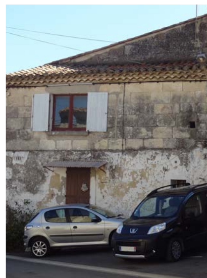
Exemple de bâti ancien dégradé dans le centre ancien de Bellegarde (photo : rue Dumas)
