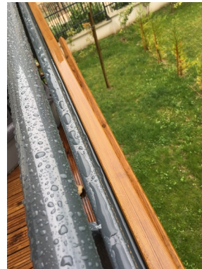
Altération (chute de lames)
