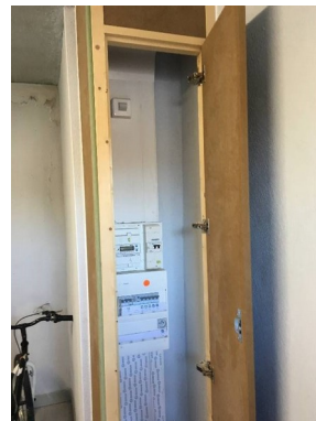
Alarme VMC absente ou mal positionnée
