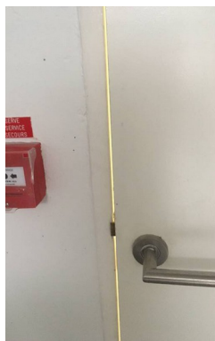
Altération du degré PF (escalier « à l'abri des fumées »)
