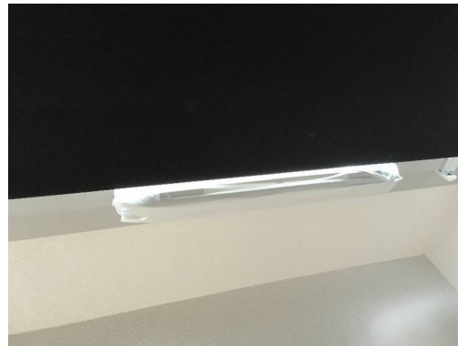
Entrées d'air absentes ou inadaptées ou obstruées
