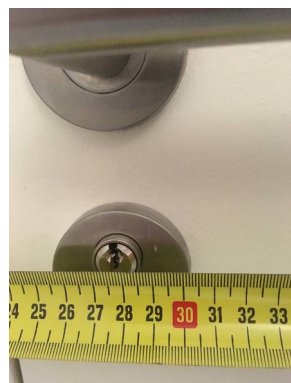
Serrure inaccessible en fauteuil
