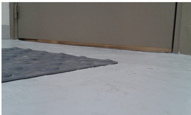
Altération du degré PF (escalier « à l'abri des fumées »)
