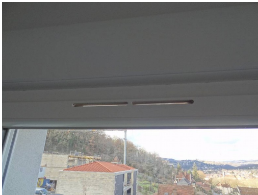
Entrées d'air absentes ou inadaptées ou obstruées
