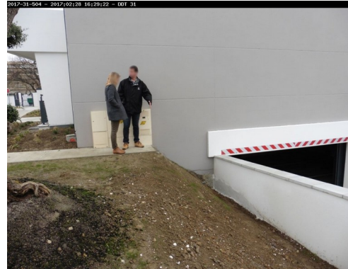
Insuffisance hauteur de garde-corps
