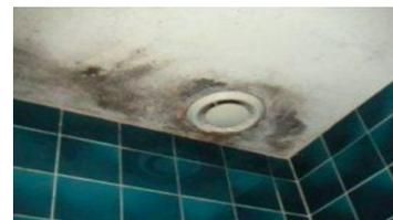
Dégradations engendrées par une ventilation défectueuse.
