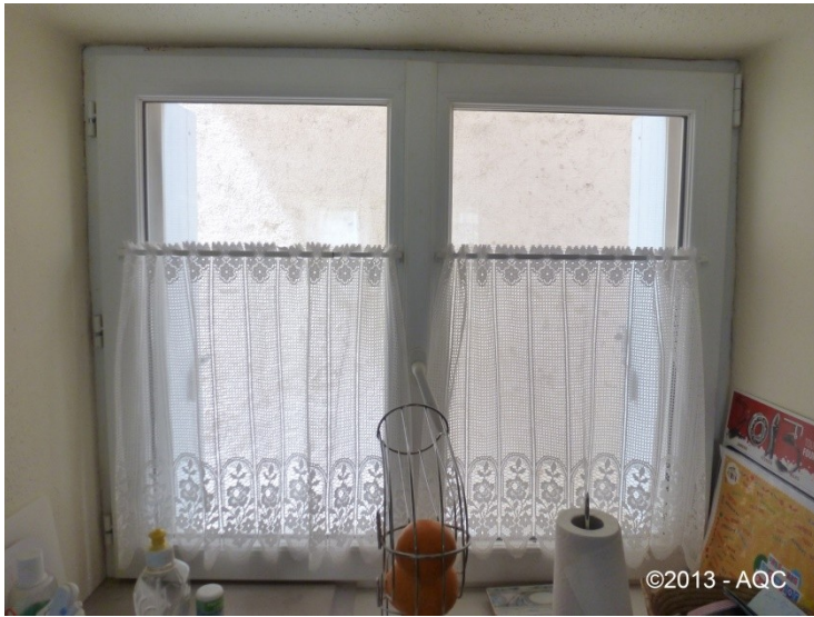
VMC SF et absence d'entrée d'air
