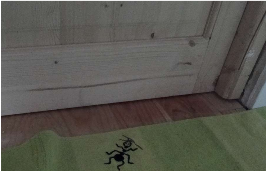
Absence de détalonnage des portes (VMC SF)
