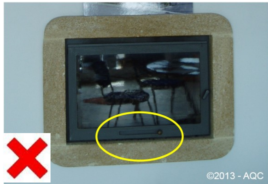
Prise d'air en façade
