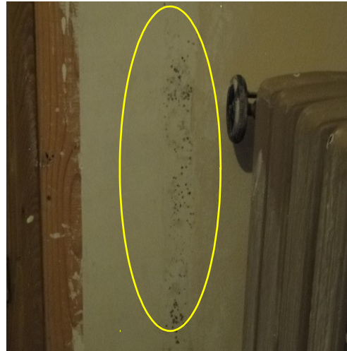
VMC SF et absence d'entrée d'air
