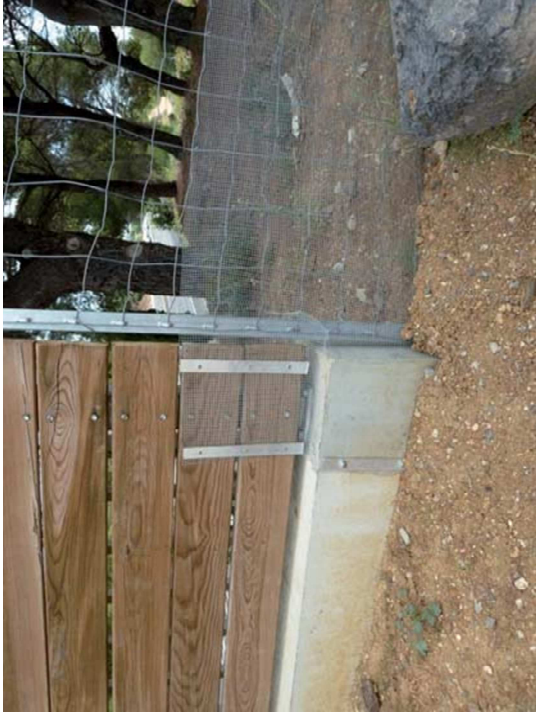
Figure 65 - Illustrations du dispositif mis en place par ASF pour un autre projet : clôture petite faune adossée à la clôture grande faune (Source : ASF)
