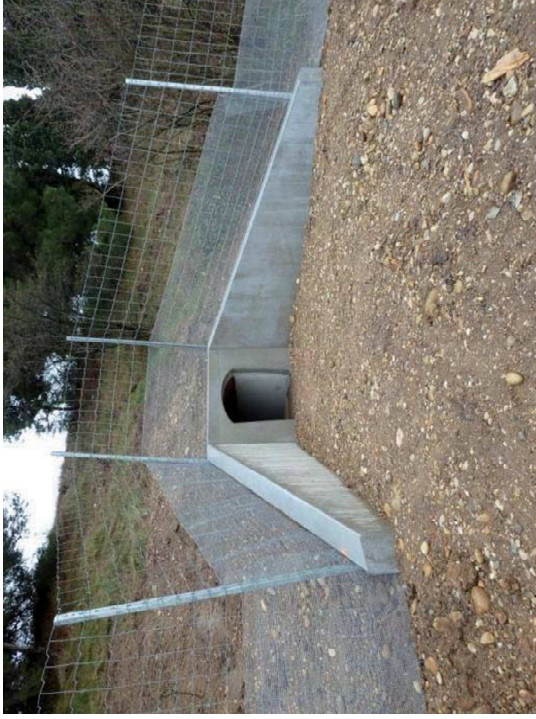
Figure 65 - Illustrations du dispositif mis en place par ASF pour un autre projet : clôture petite faune adossée à la clôture grande faune (Source : ASF)
