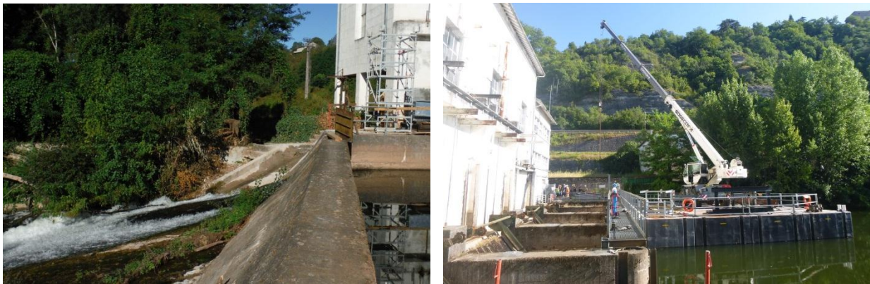
Figure 11 – Accès à l'aval du déversoir depuis la dalle de circulation / Grue 45 T sur la plateforme flottante 2016
