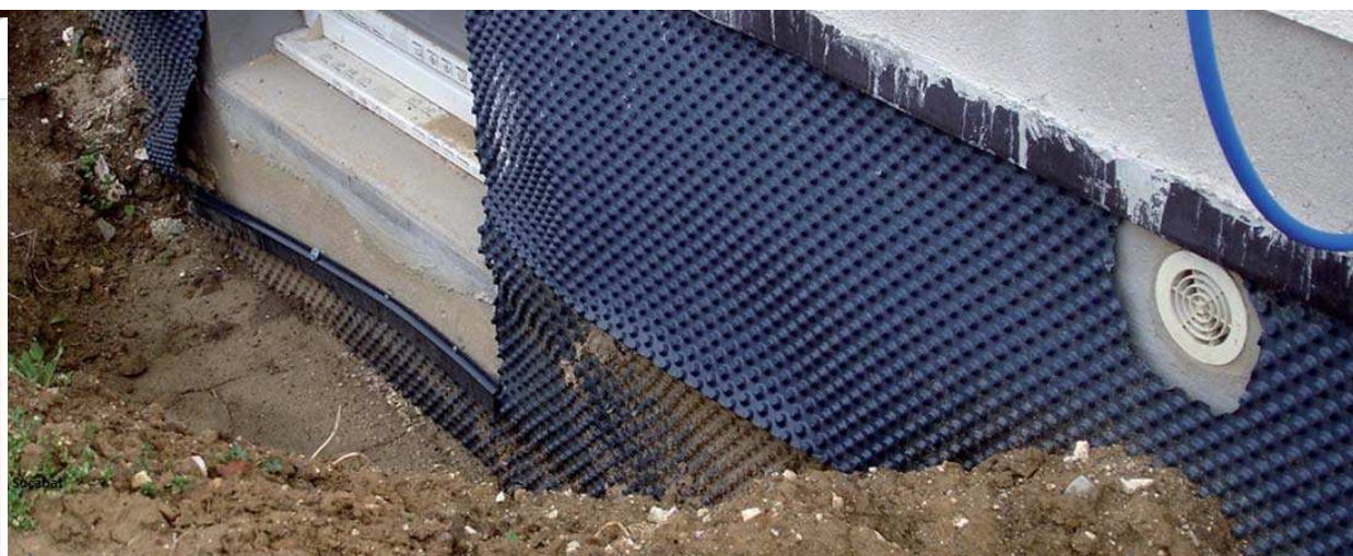
Configuration de drainage adaptée aux sols sensibles à l'eau.
