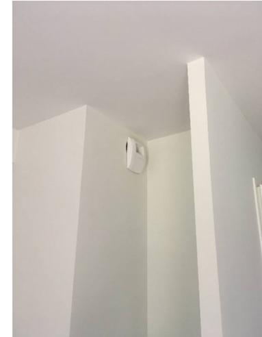
Bouches d'extractions inadaptées ou mal positionnées
