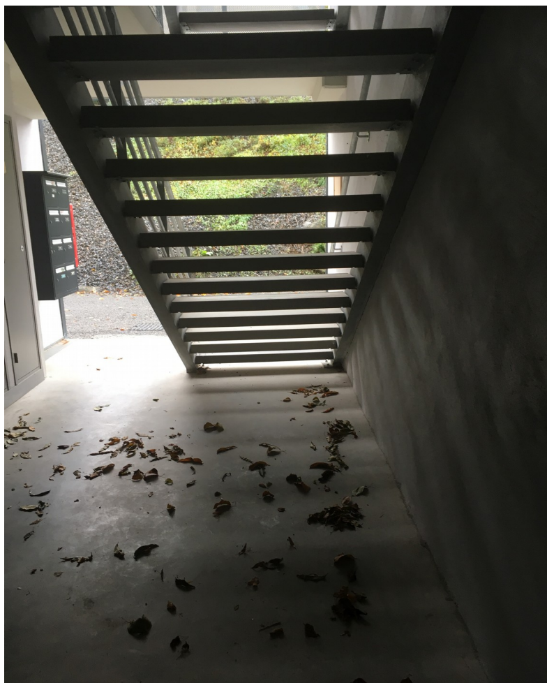
Sous-escalier non protégé
