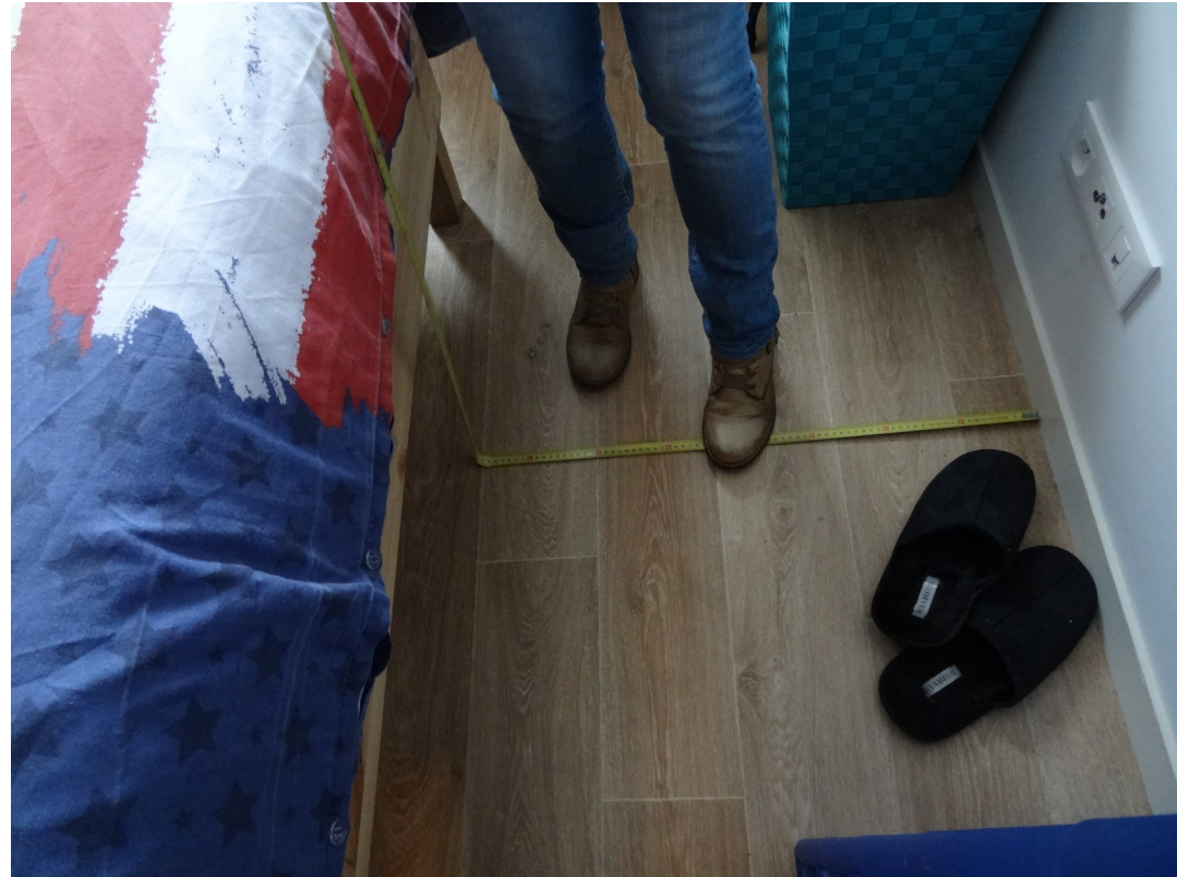
Absence de débattement suffisant autour du lit
