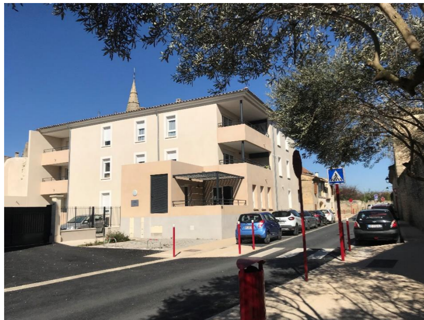
Maison de Lagarde à BEZOUCE – Un Toit pour Tous
