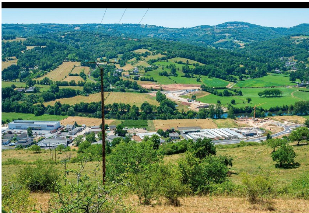
DEVIATION D'ESPALION - OPP Nord Aveyron
