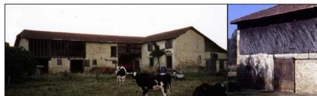
Ferme équerre avec treillis en bois caractéristique qui éclairait et ventilait les annexes
