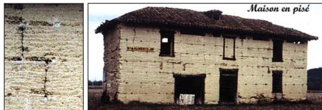
Maison en pisé, appareillage de gros blocs de terre compactée
