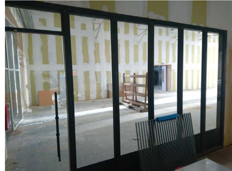
Menuiserie réemployée in situ
