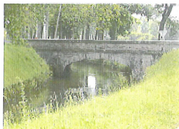
Voute en arc de plein cintre sur la rigole de la plaine
