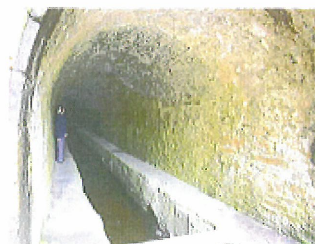
Le tunnel des Caussegras
