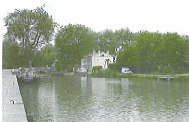
Ensemble port, quai, maison éclaireur à Gardouch
