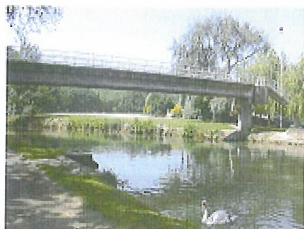
Passerelle béton à Castelnaudary
