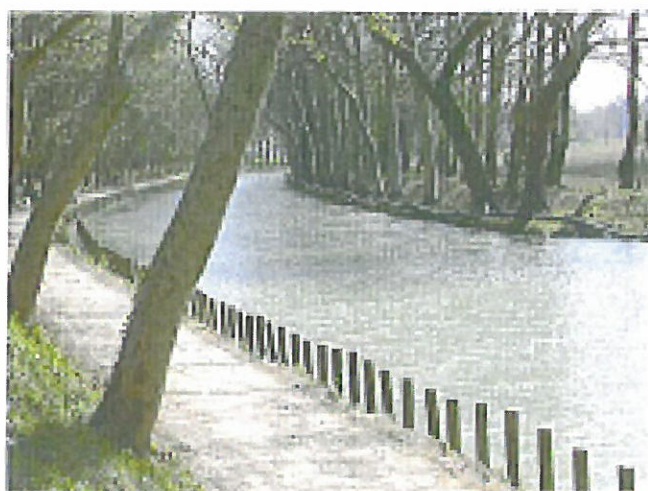
Renforcement de berge par tamage
