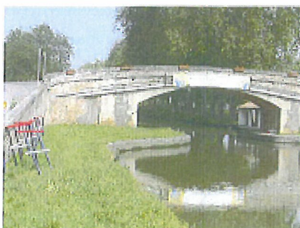
Pont du Segala
