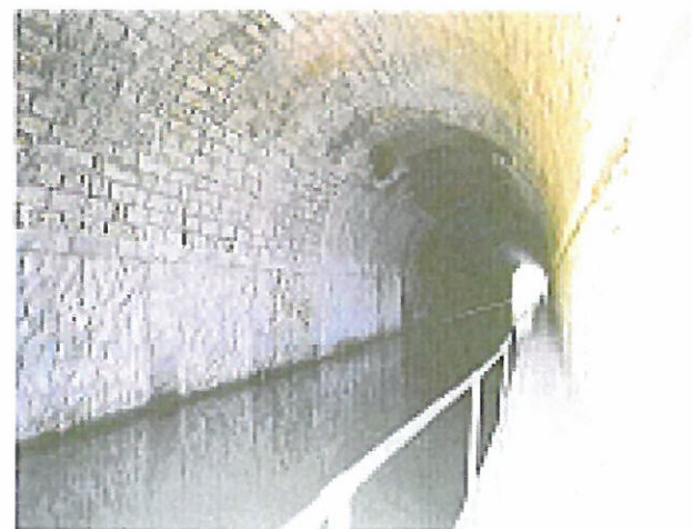
Le tunnel du Malpas
