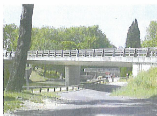
Pont de la rocade de Carcassonne
