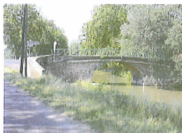
Pont de Roubia, décoratifs formelles (parapet métallique passage de canalisations)
