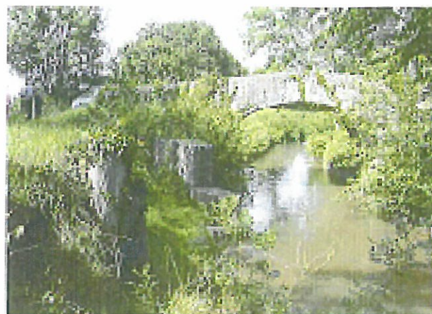
Pont sur la rigole de la plaine
