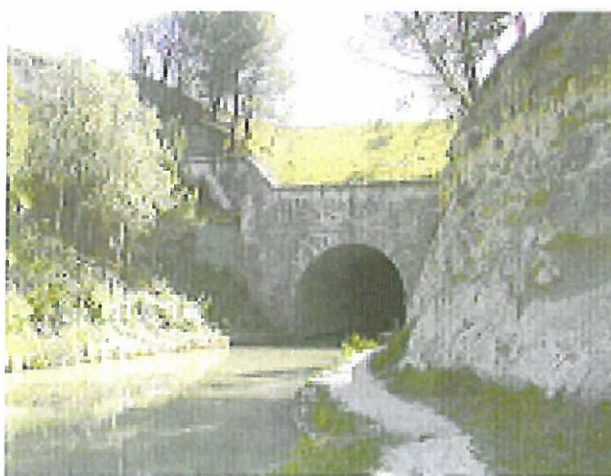
Le tunnel du Malpas
