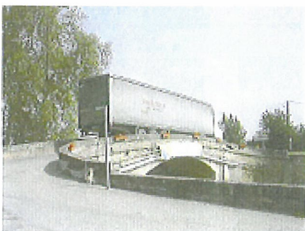
Pont du Segala
