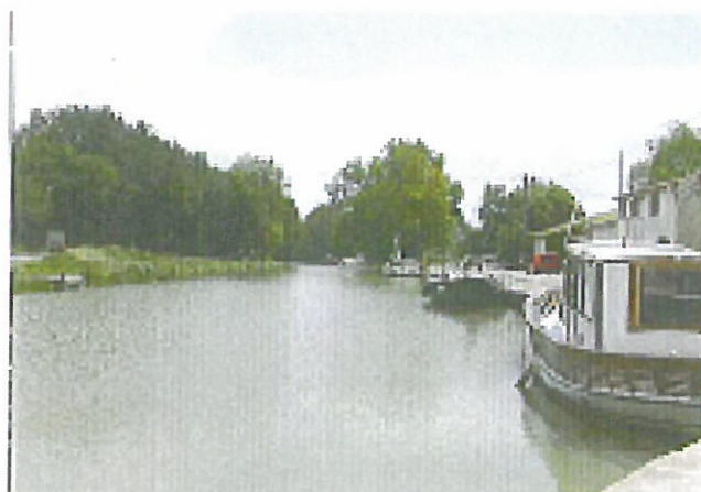
Évasement du canal en port à Gardouch
