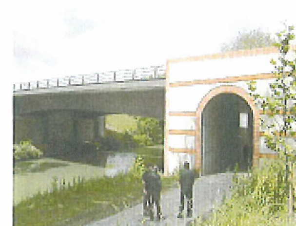
Pont de l'autoroute A 65 à Montesquieu - Lesoregas
