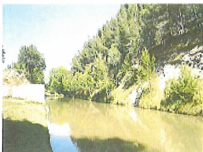
Berges abruptes aux abords du tunnel du Malpas
