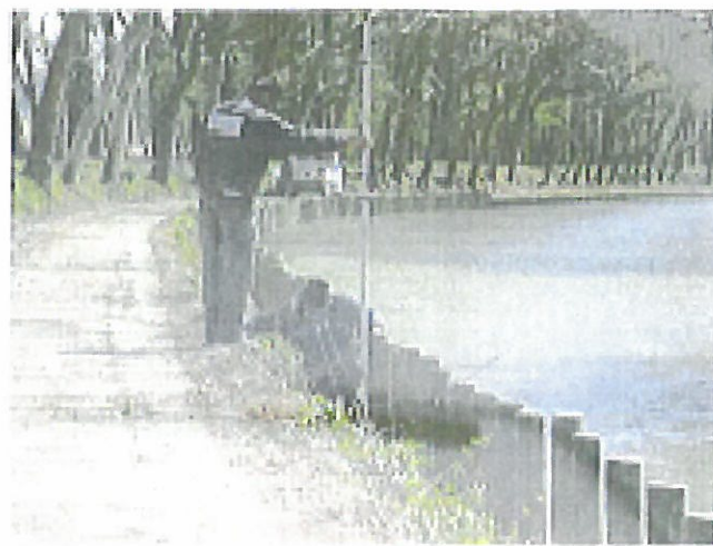
Renforcement de berge par tamage
