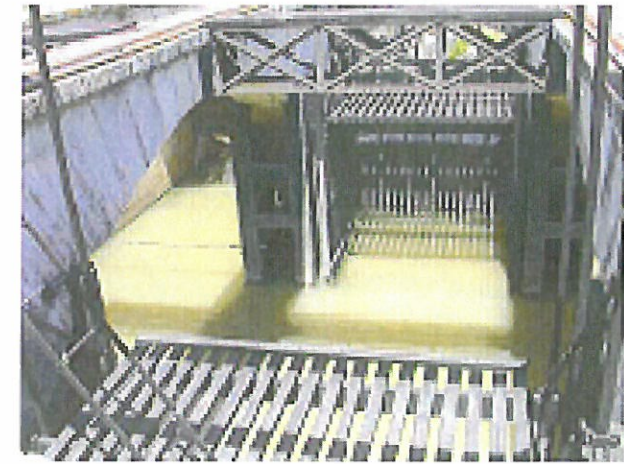
L'ouvrage du Libron (aquéduc noble)
