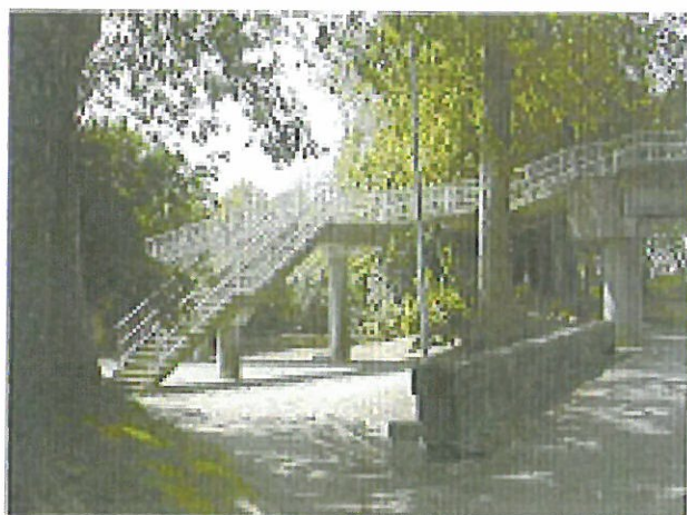
Passerelle béton à Castelnaudary
