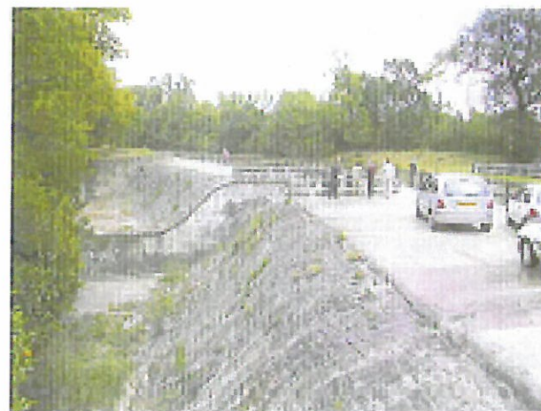
L'aqueduc et l'épandoir de Orens
