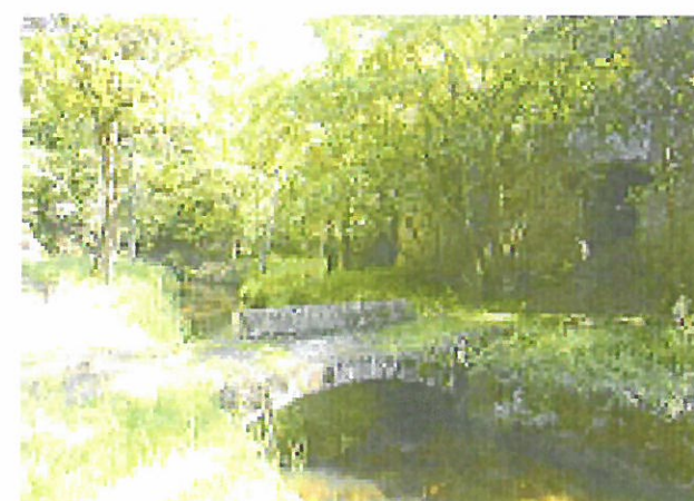
Pont d'Arzac sur la rigole de la Montagne
