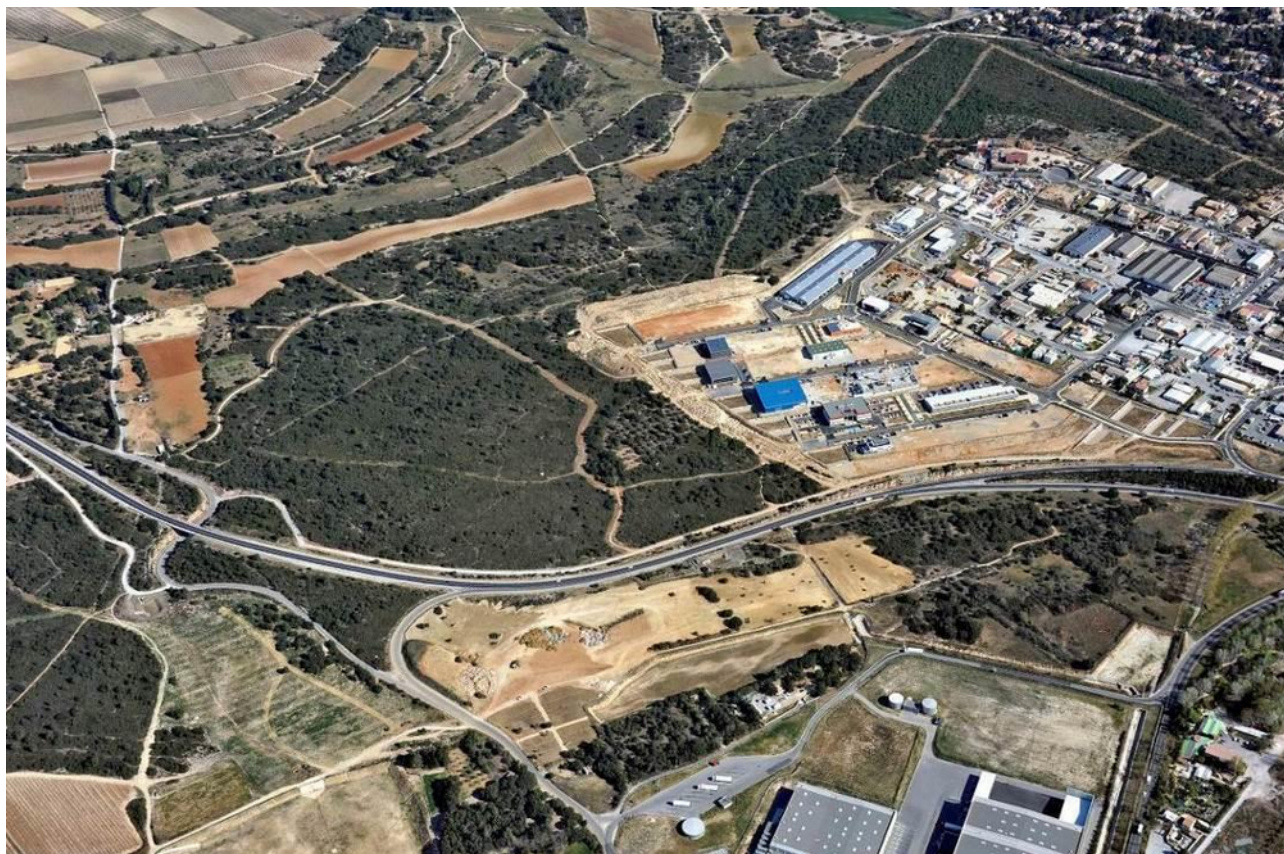
Vue aérienne de la zone d'emprise
