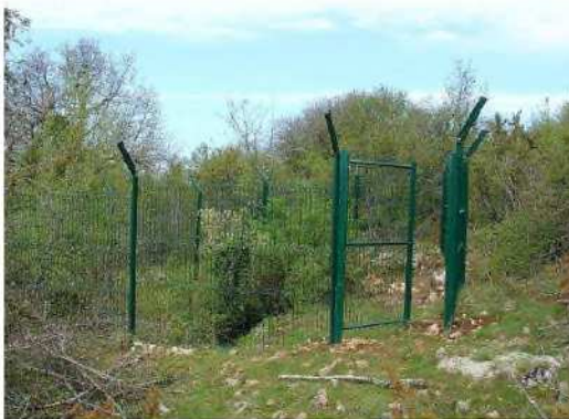
Un des périmètres grillagés installés au printemps 2005 autour des entrées de la grotte de Magnagues (SIC n°5) (© M. NEMOZ)
