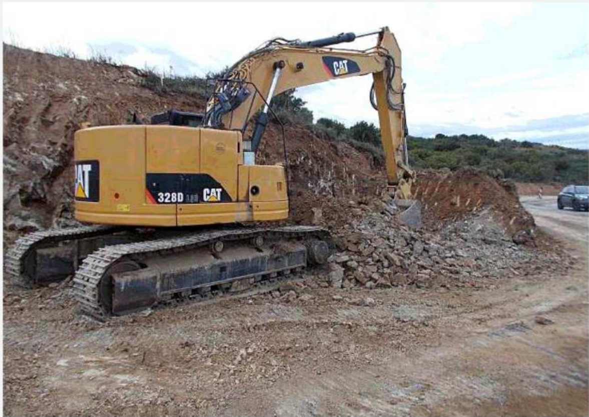
☞ Photographie : Pelleteuse à l'arrêt à l'avancement de la découpe du front de taille
