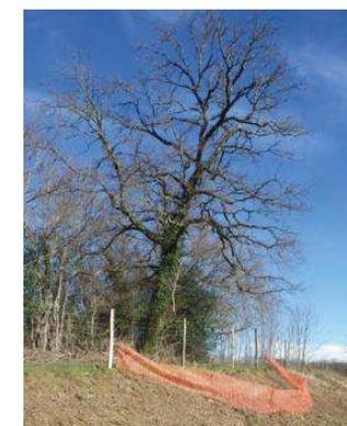
Figure 13 : Exemples de mises en défens sur un chantier
