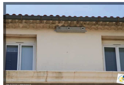
Exemple de pose de nichoir 17A à martinets (source : Toulon Provence Méditerranée)
