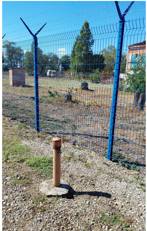
Vue éloignée de l'ouvrage
