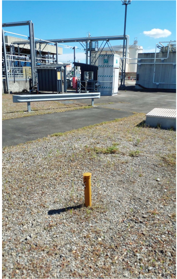
Vue éloignée de l'ouvrage
