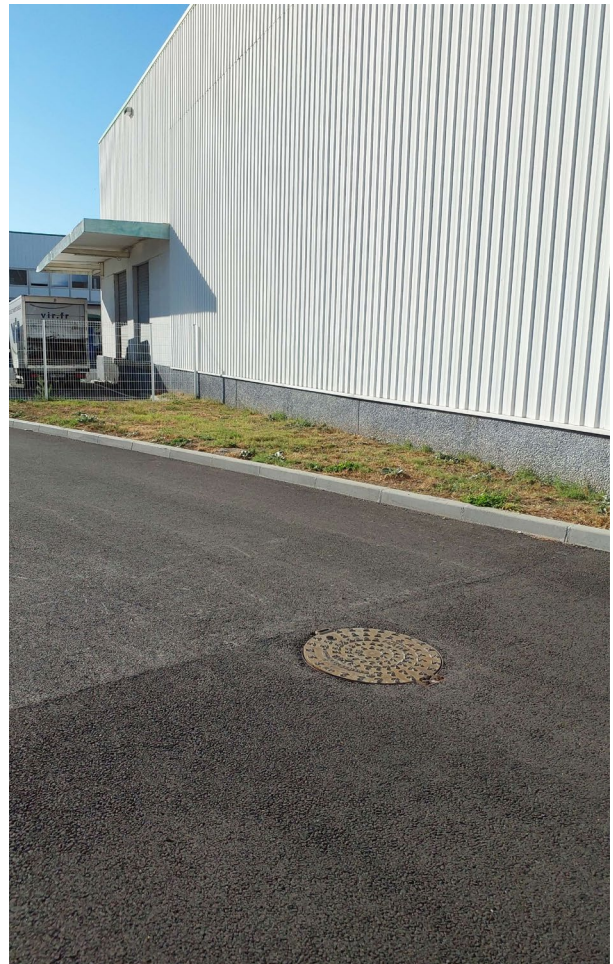
Vue éloignée de l'ouvrage
