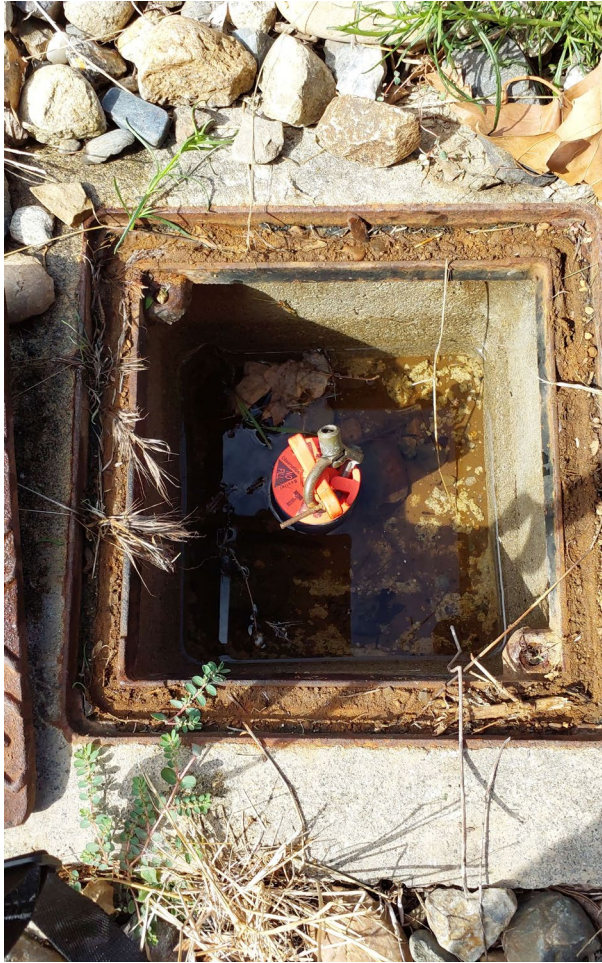
Vue de près de l'ouvrage
