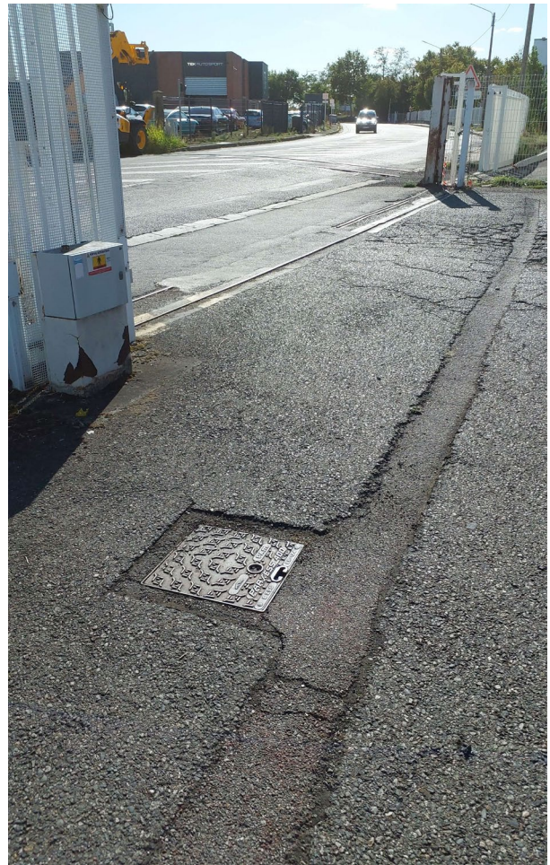
Vue éloignée de l'ouvrage
