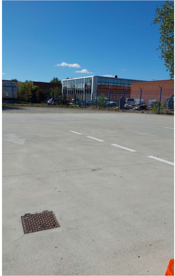
Vue éloignée de l'ouvrage
