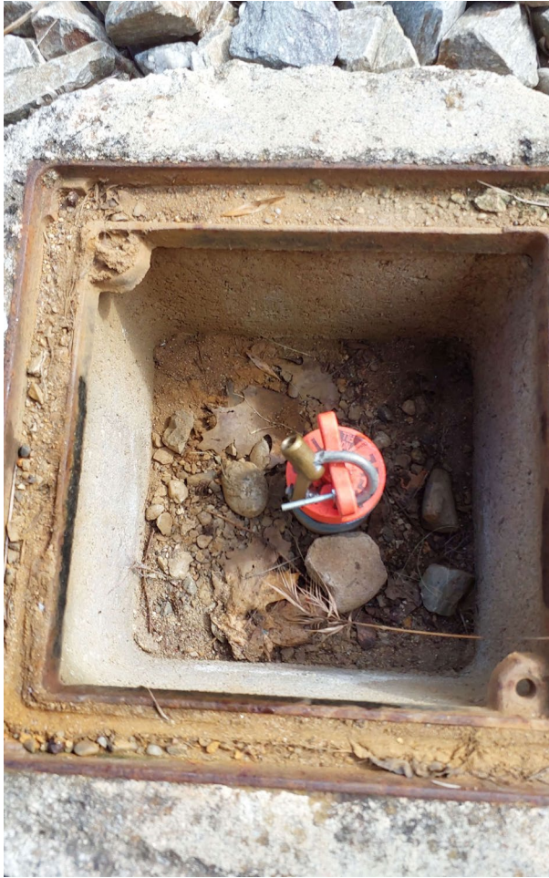
Vue de près de l'ouvrage
