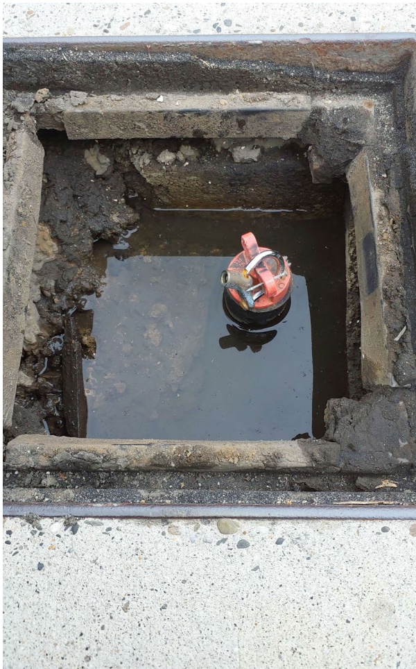
Vue de près de l'ouvrage
