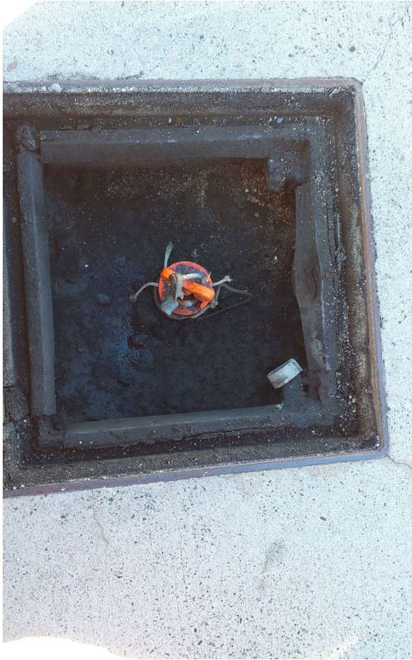
Vue de près de l'ouvrage
