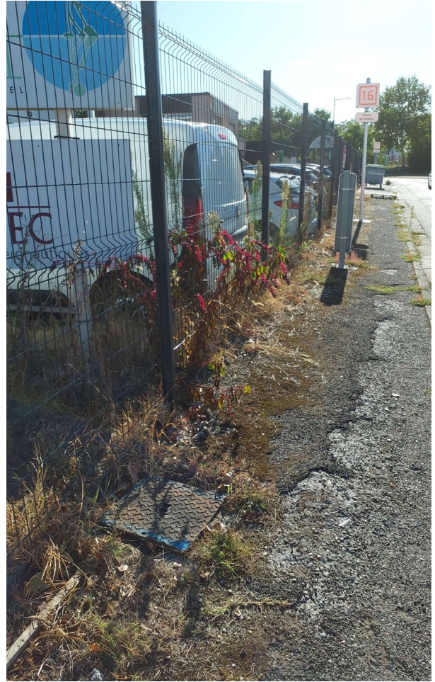
Vue éloignée de l'ouvrage
