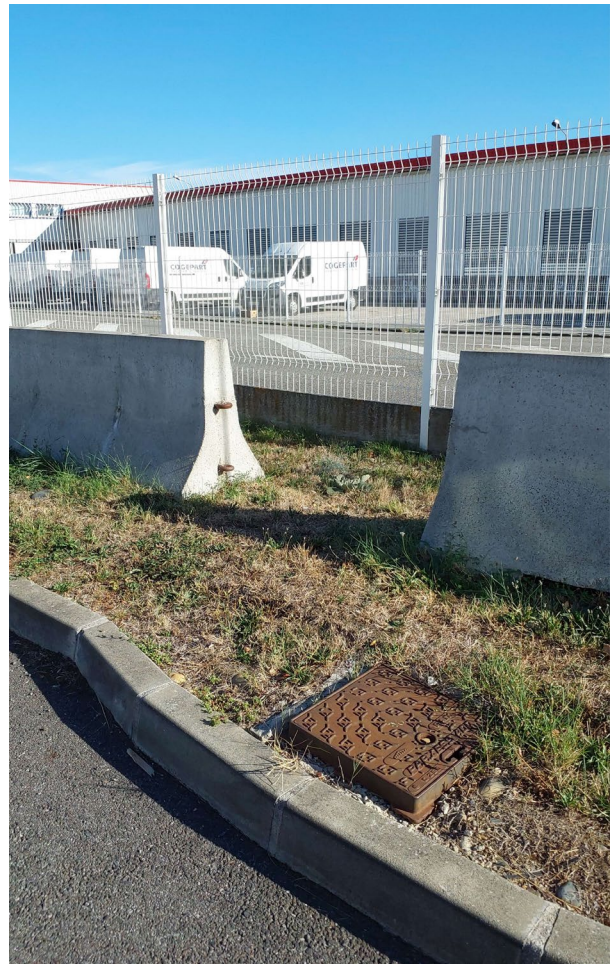
Vue éloignée de l'ouvrage
