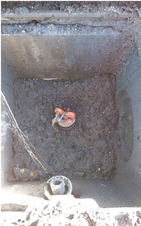
Vue de près de l'ouvrage
