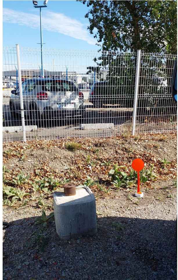
Vue éloignée de l'ouvrage
