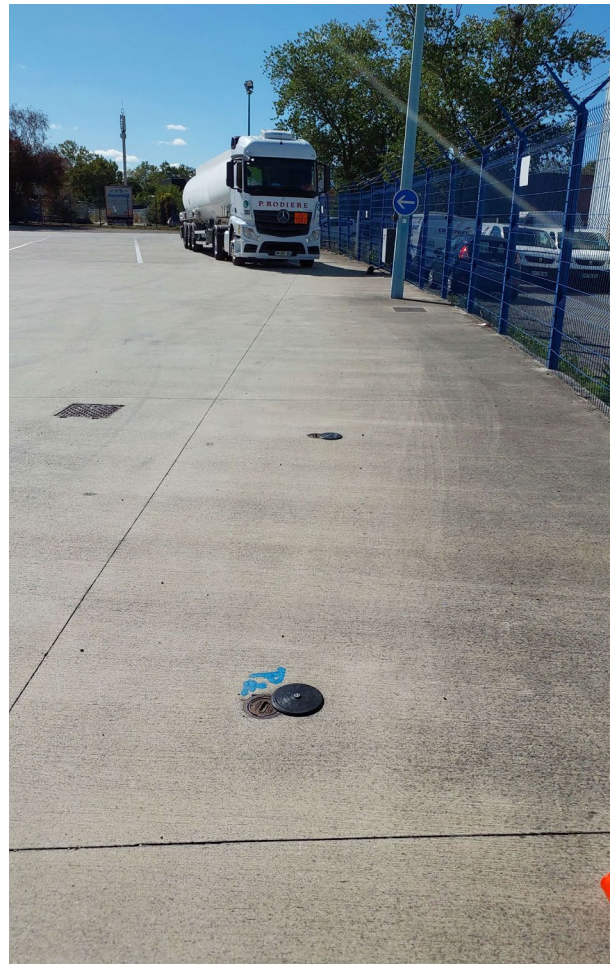
Vue éloignée de l'ouvrage
