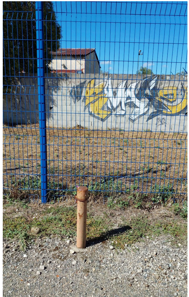
Vue éloignée de l'ouvrage
