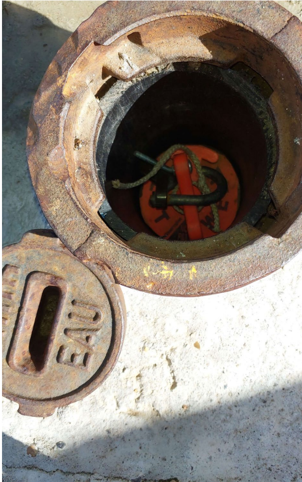
Vue de près de l'ouvrage
