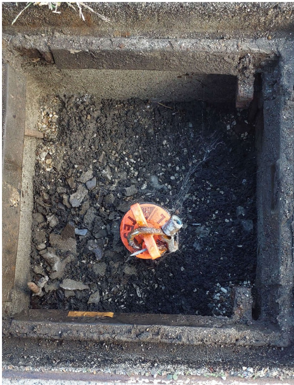
Vue de près de l'ouvrage
