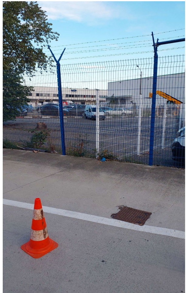
Vue éloignée de l'ouvrage
