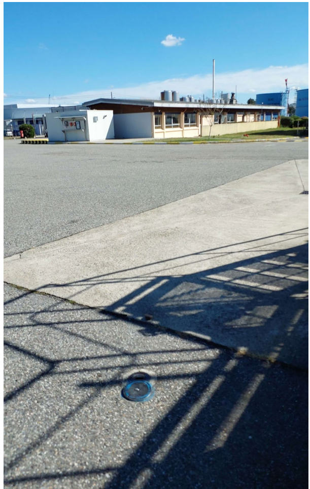
Vue éloignée de l'ouvrage
