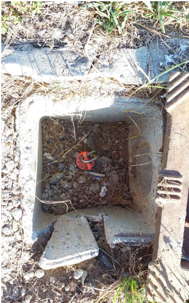
Vue de près de l'ouvrage
