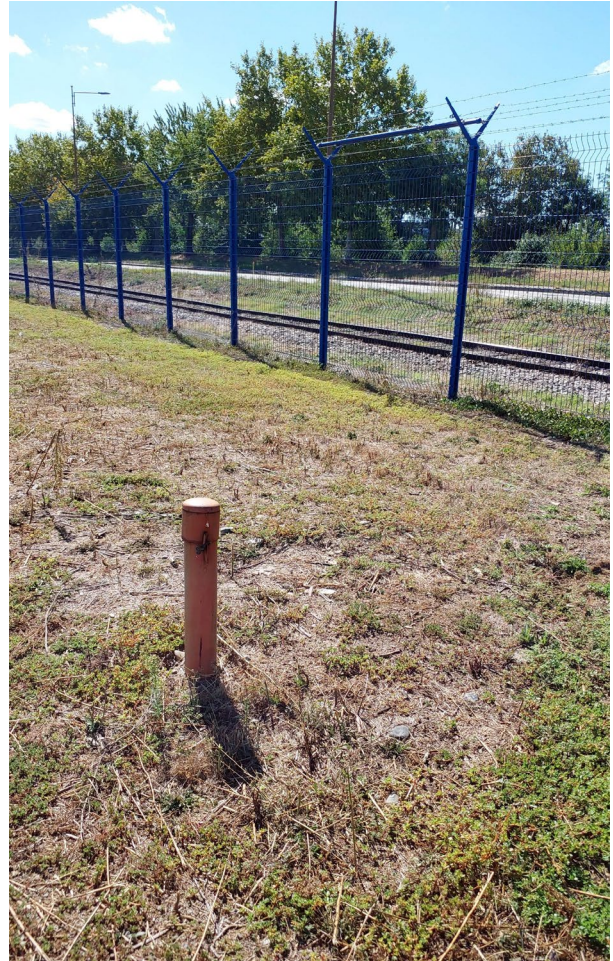
Vue éloignée de l'ouvrage
