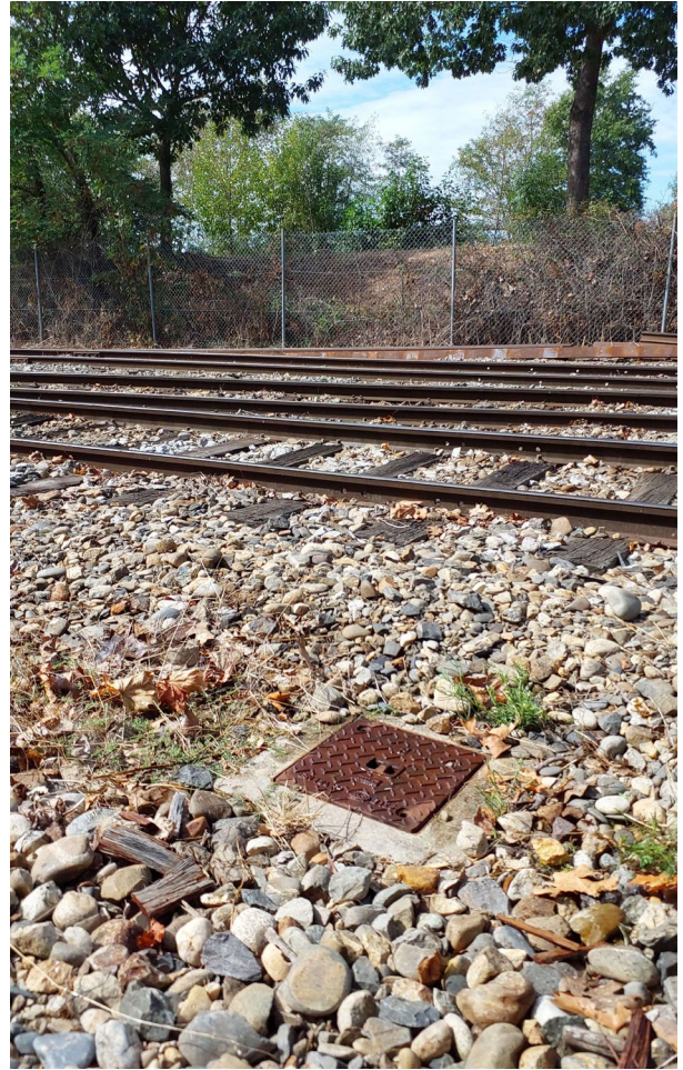
Vue éloignée de l'ouvrage
