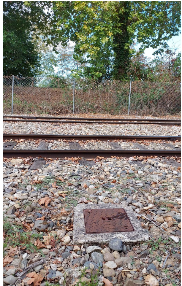
Vue éloignée de l'ouvrage
