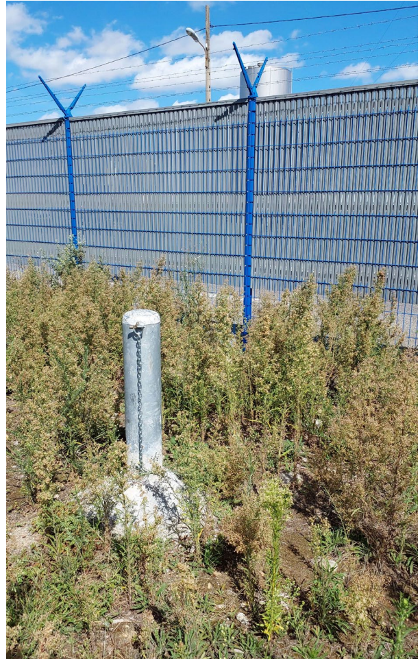
Vue éloignée de l'ouvrage
