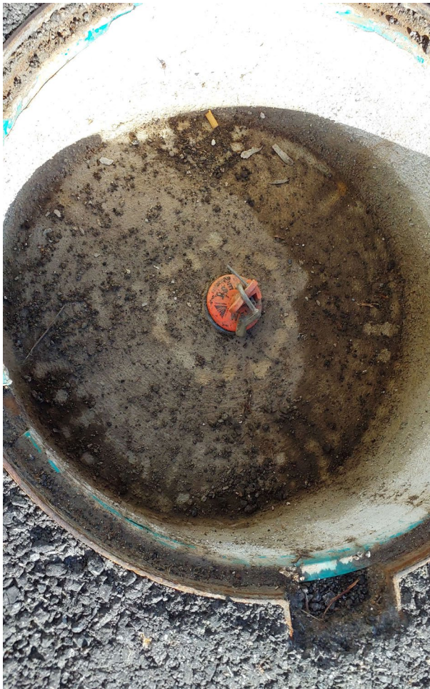
Vue de près de l'ouvrage
