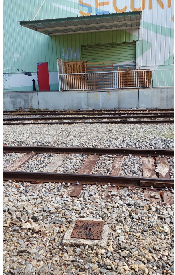
Vue éloignée de l'ouvrage
