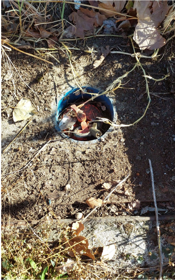
Vue de près de l'ouvrage
