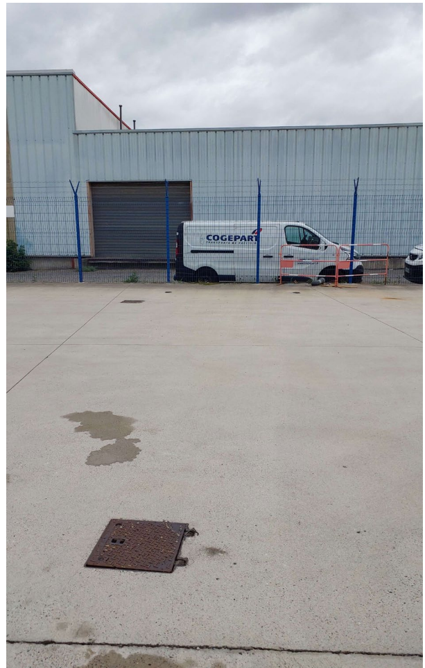
Vue éloignée de l'ouvrage
