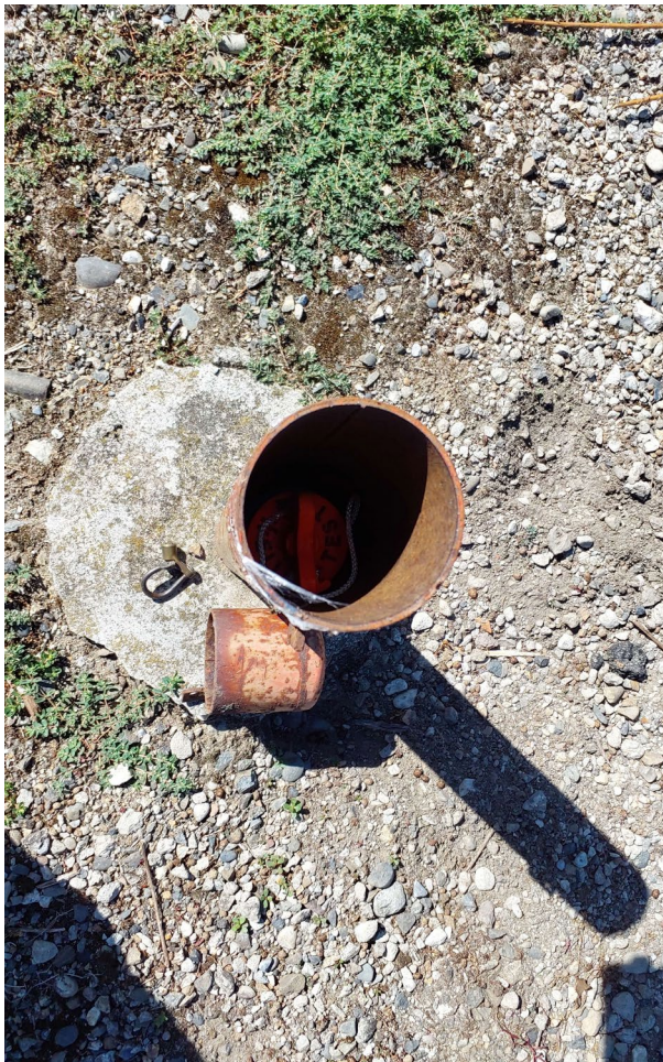
Vue de près de l'ouvrage
