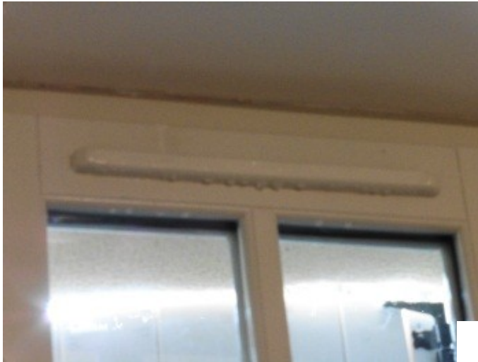
Problème d'humidité sur grille d'aération
