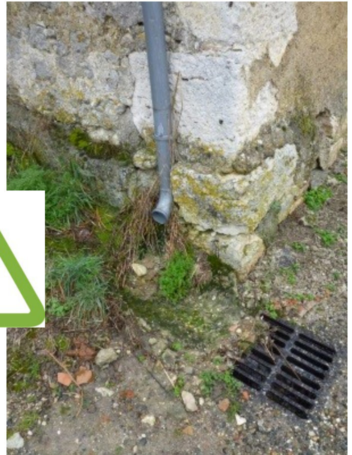
Descente EP non raccordée au réseau existant
