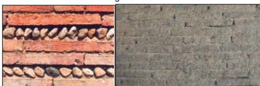
Appareillage briques/galets et brique de terre crue
