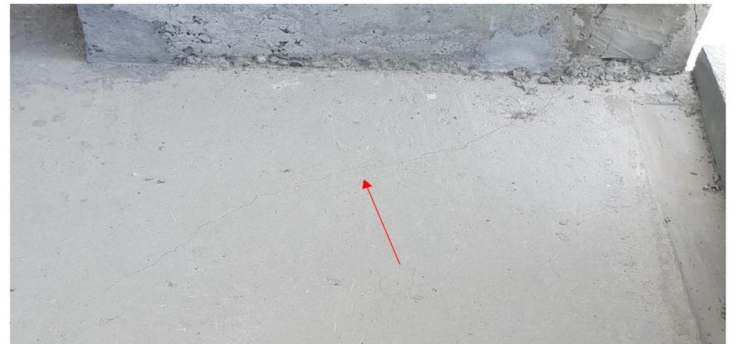
Ces fissures ont une ouverture qui varie, en fonction des balcons de 1/10<sup>ème</sup> à 6/10<sup>ème</sup> mm
