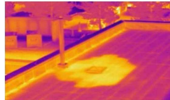
Exemple de constat thermique
