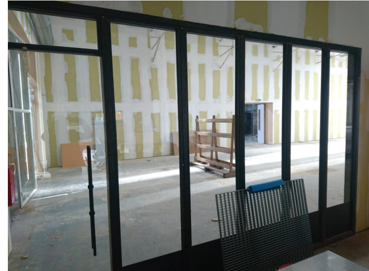
Menuiserie réemployée in situ
