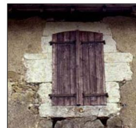
Détail d'une fenêtre : l'enduit terreux ne laisse apparentes que les pierres de taille
