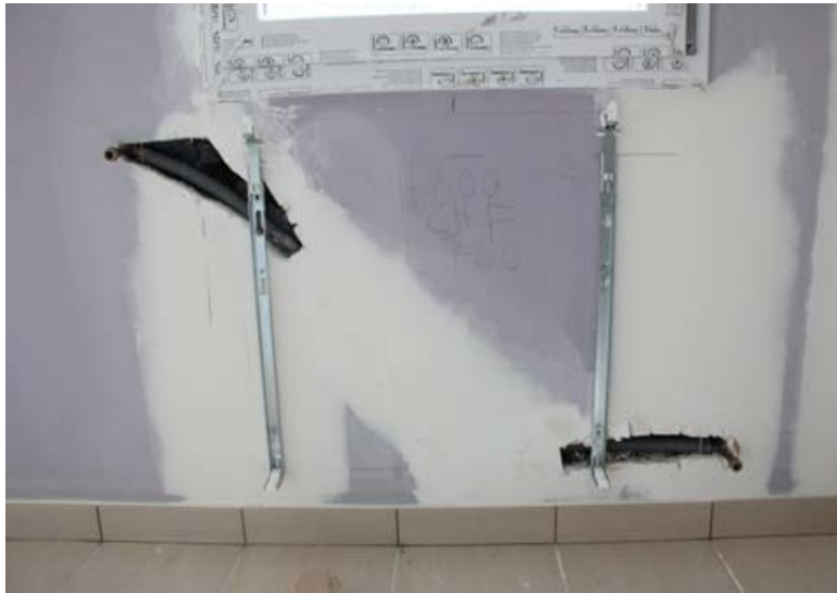
Allongement des tuyaux du radiateur plus petit permettant l'ouverture de la fenêtre
