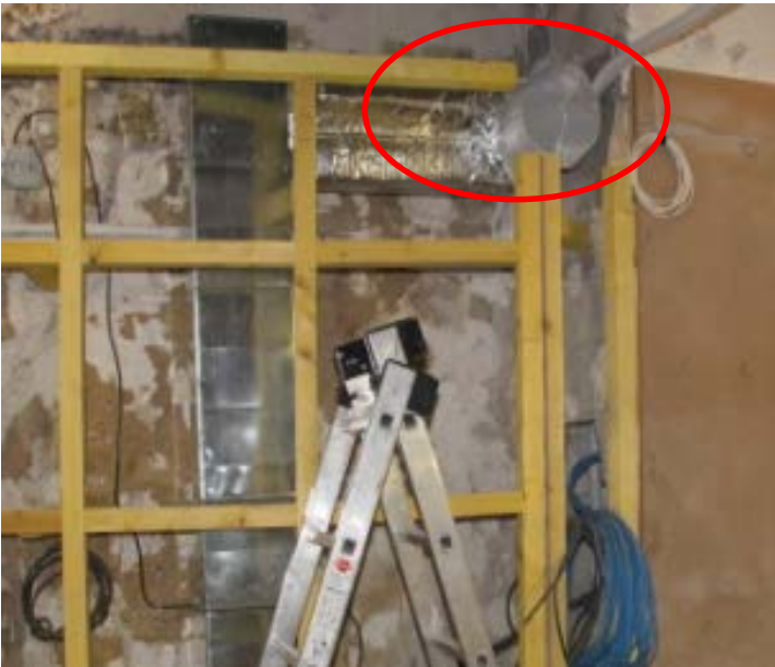
Tasseaux coupés permettant le passage du coude de la gaine de ventilation
