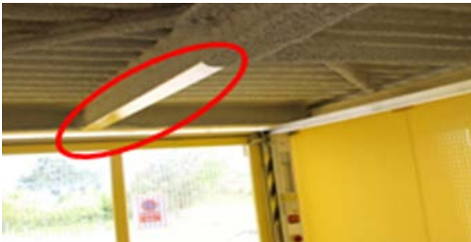
Flocage arraché pour permettre l'ouverture du portail de garage
