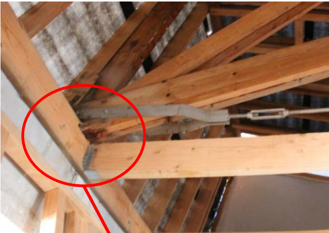
Panne de la charpente renforçant la charpente
