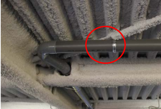
Collision entraînant la destruction du flocage du contreventement du plancher haut
