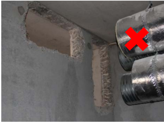
Réservation des gaines de ventilation faites après coulage.
