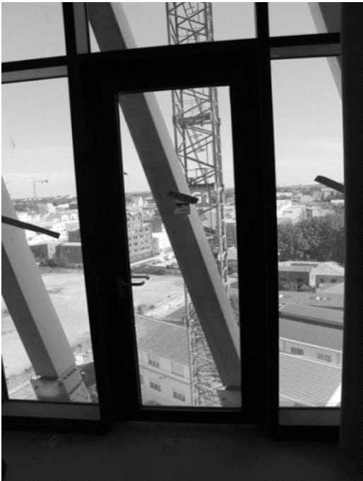
Le montant du bardage obstruant le passage de l'issue de secours
