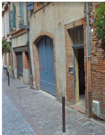
Cabinet de thérapeute en site patrimonial remarquable
