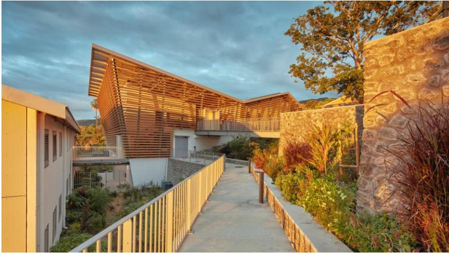
Les bâtiments de bureaux ont une géométrie permettant de ventiler chacun des bureaux d'une façade à l'autre.
