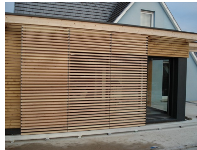
Brise-soleil vertical à l'Ouest
