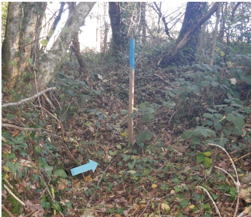
Illustration 12 : Localisation de la sortie du déversoir d'orage (masqué en partie par la végétation)
