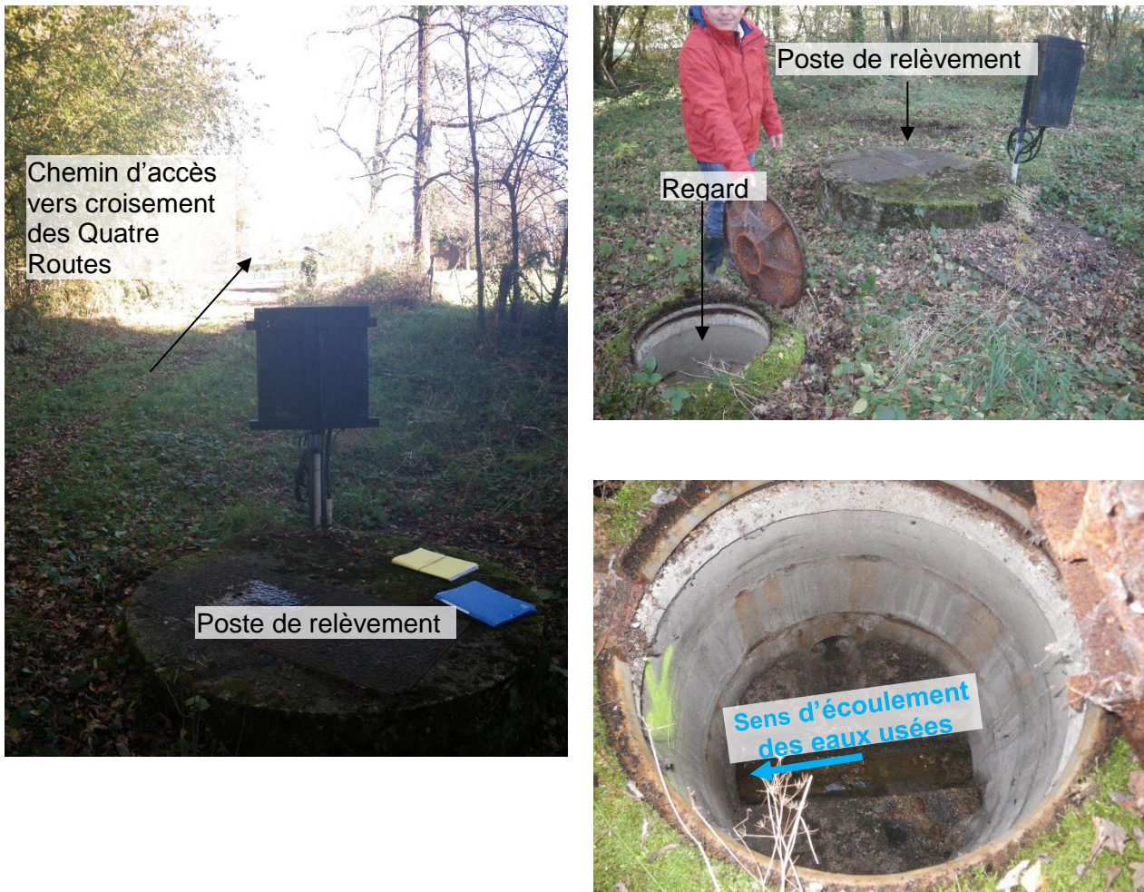
Illustration 11 : Poste de relèvement des eaux usées, sens d'écoulement vers l'exutoire
