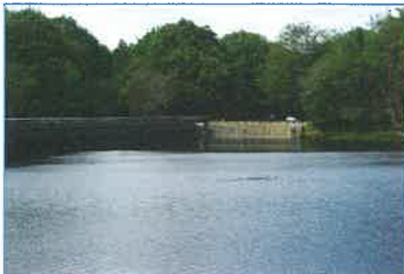
Barrage de Saint-Denis – Rive Gauche (1)
