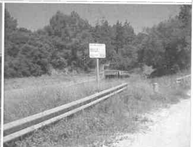
Entrée de la partie souterraine du canal des Costières.
