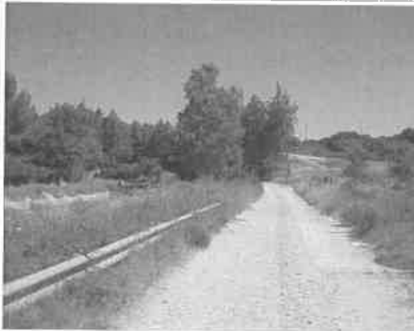
Canal à ciel ouvert avec contre piste BRL et glissière de sécurité métallique. En arrière plan, la nouvelle piste entre le site des CET SITA et les stocks de déblais inertes SITA
