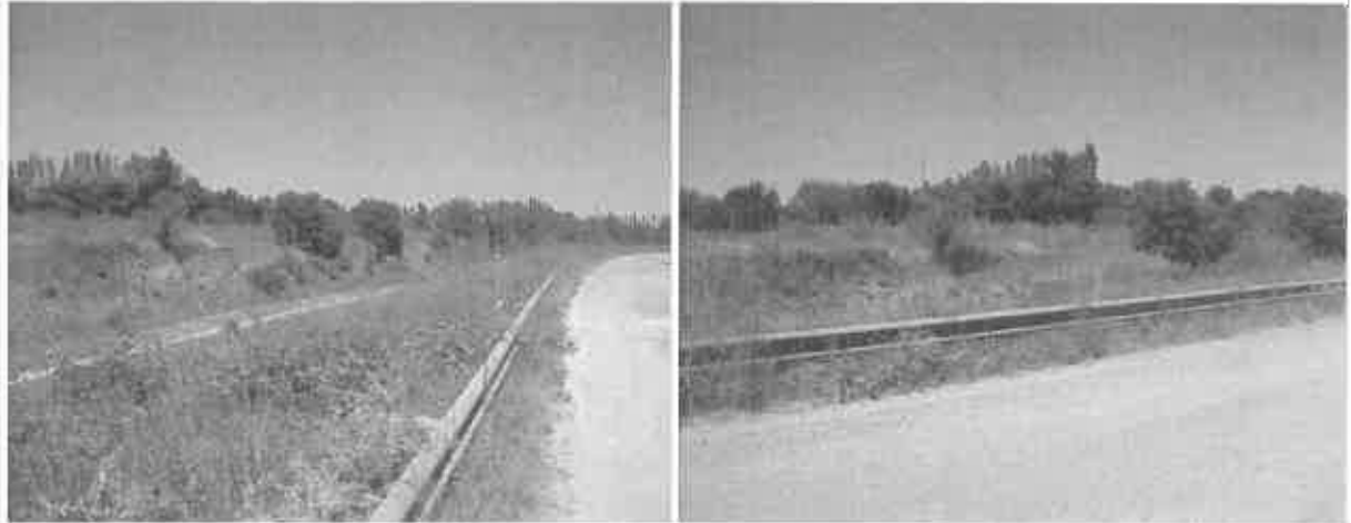
Zone de franchissement du canal à l'extrémité nord de la peupleraie du Mas GONET.
