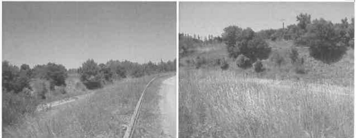
Appréciation du contexte topographique : la rive ouest est plus haute que la rive est (coté nouvelle piste).
