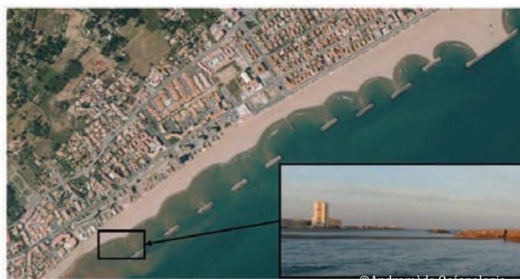
Photographie 1 : Accentuation sédimentaire derrière un enrochement artificiel de Valras-Plage constaté entre 2009 (date de la photographie aérienne) et 2012 (date de la photographie de vérité terrain)
