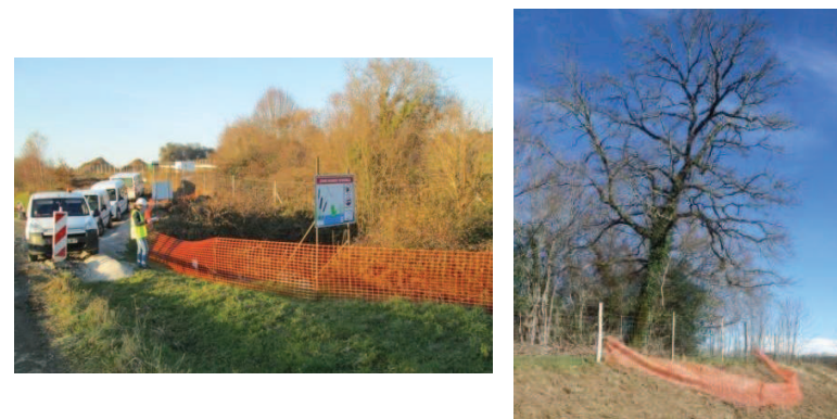
Figure 71 : Exemples de mises en défens sur un chantier
