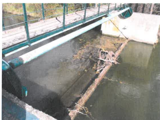
Vues détaillées du barrage anti-sel sur la Cadoule et des éléments détériorés de la pelle © Biotope
