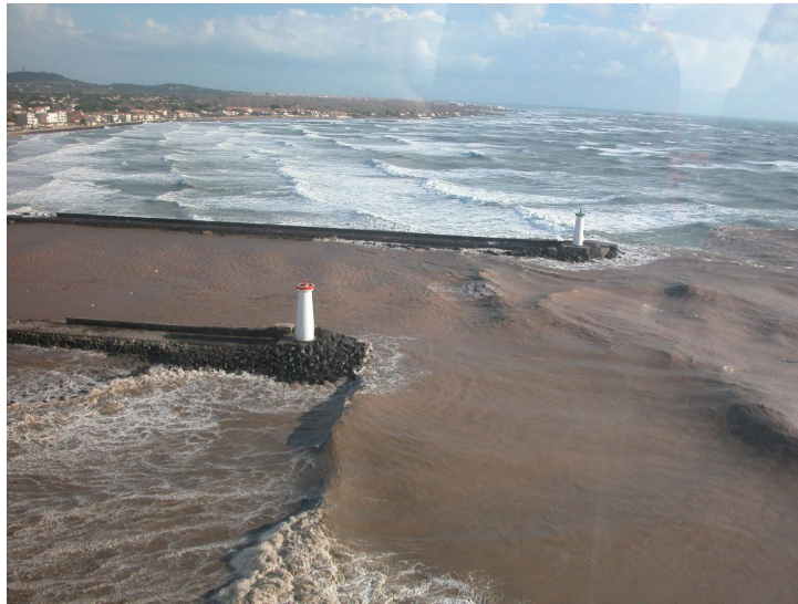
Ressaut hydraulique a l'embouchure de l'Hérault le 4 décembre 2003 à 12h
