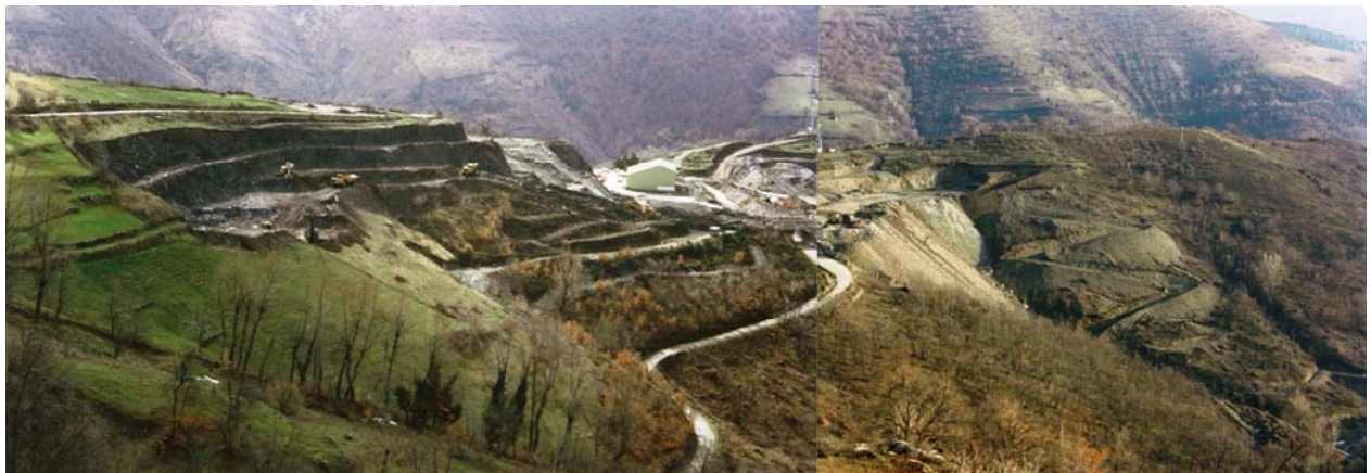
Site des Bondons en exploitation (mai 1987) avec la carrière pilote sur la gauche, et la verse en cours de constitution sur la droite
