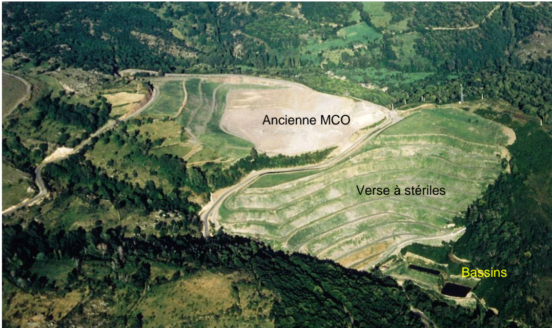
Vue aérienne du site après les travaux de réaménagement en 1990
