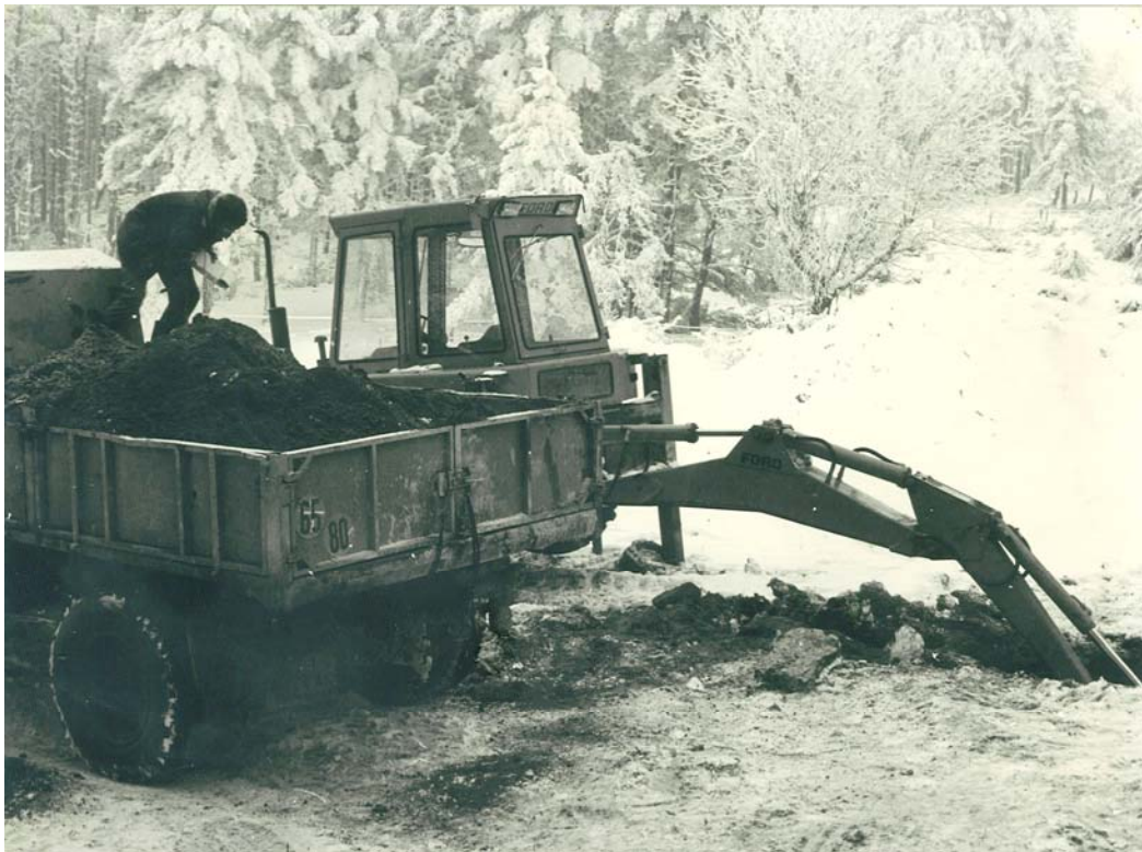
Travaux de recherche sur le site de la Rouchette en 1979
