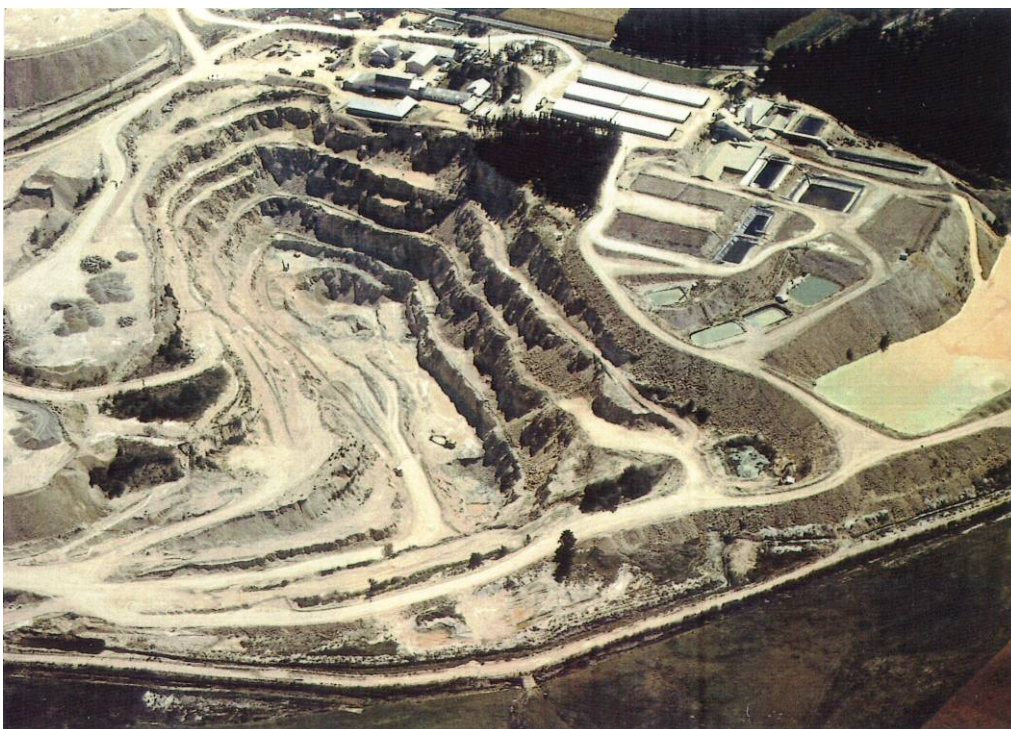
Mine à ciel ouvert du Cellier en cours d'exploitation, stalles de lixiviation et bassins de décantation (1974)
