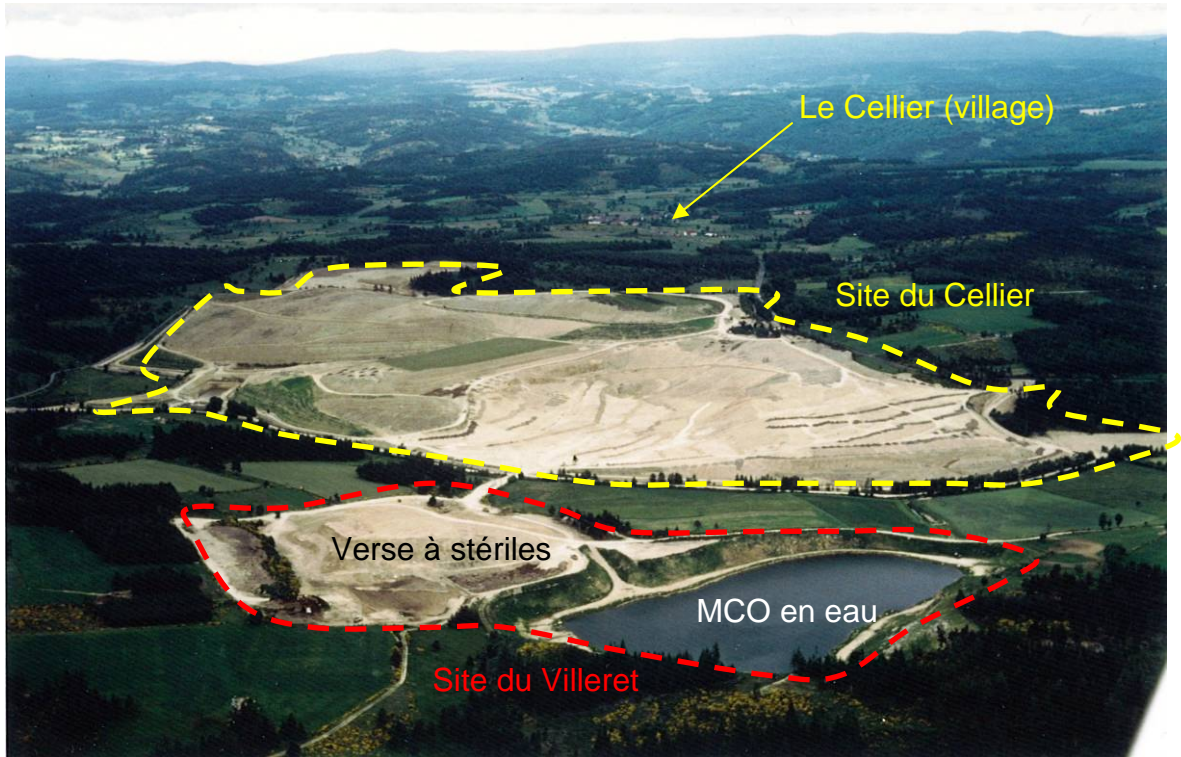
Site du Villeret après travaux de réhabilitation en 1991
