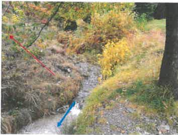
Vue 3 : Ruisseau de la maison forestière – Busage pour remblais en rive droite nouvelle voie (23.10.2013)
