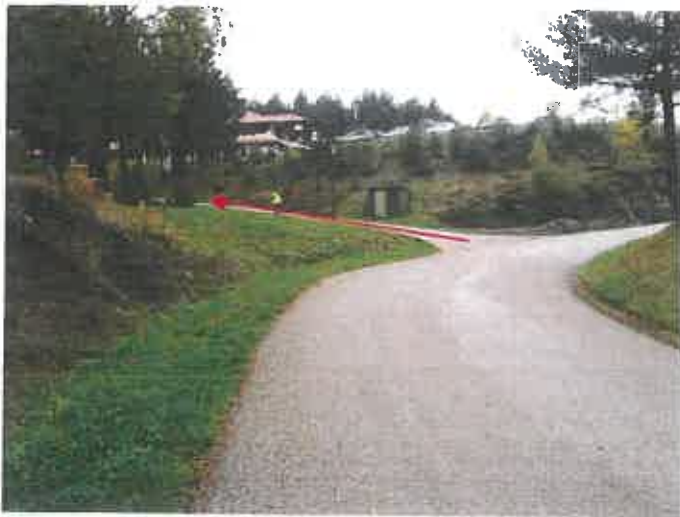
Vue 1 : Début des travaux sur la voie communale (23.10.2013)
