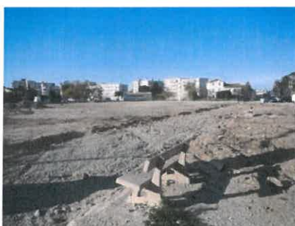
Photo 4: Terrain avant travaux
