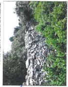
Vue du cloaque à restaurer et à vitrifier
