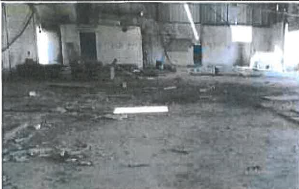
Vue Nord de l'intérieur du bâtiment restant
