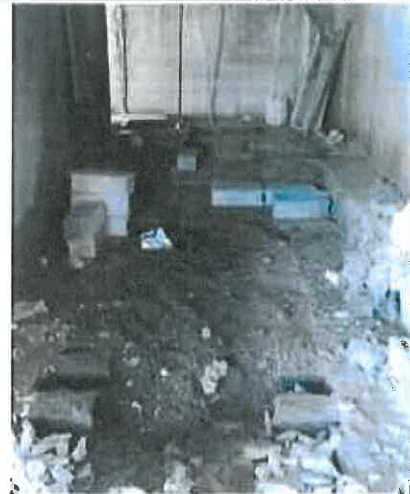
Vue du local groupe électrogène du bâtiment restant
