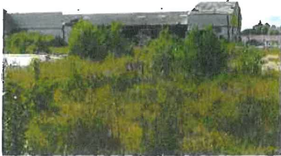
Vue de la face Est du bâtiment restant
