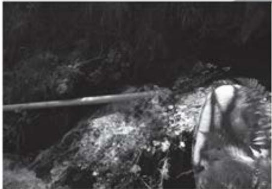
Captage en aluminium sans protection posé en continu dans la rivière d'Urbanya permettant de remplir une cuve d'eau (diamètre=7,5cm). Evalué très dangereux.
