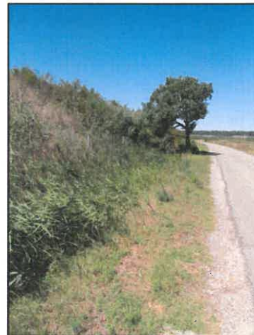
Talus au nord-est de l'autoroute
