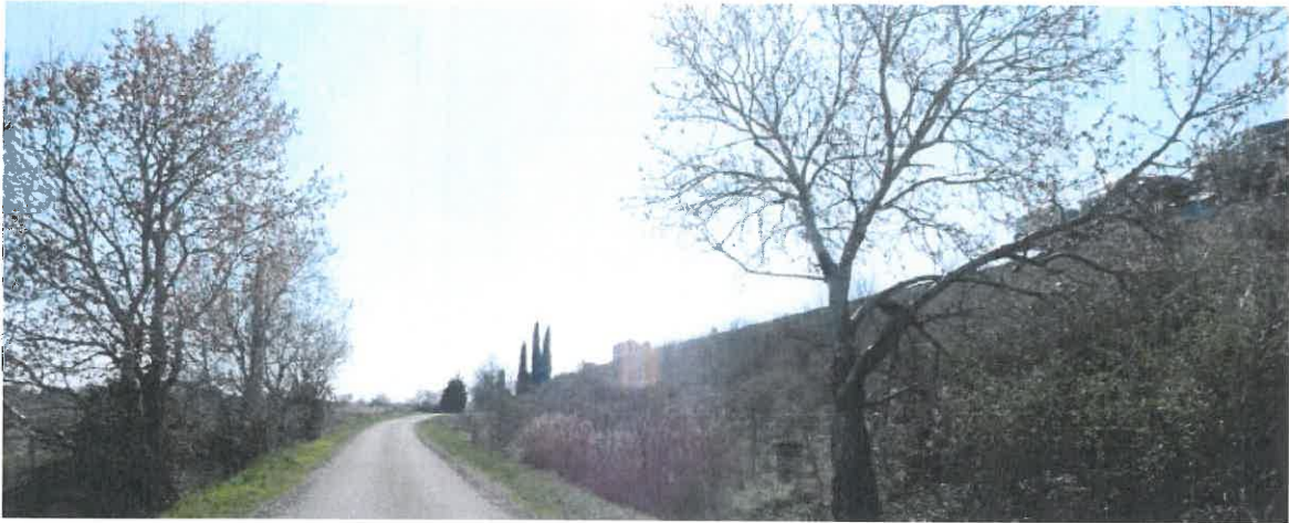
Vue du site, côté Ouest
