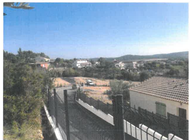
Création du lotissement « les Arbousiers » Photo : ONF Pôle DFCI 30-34-48 novembre 2015
