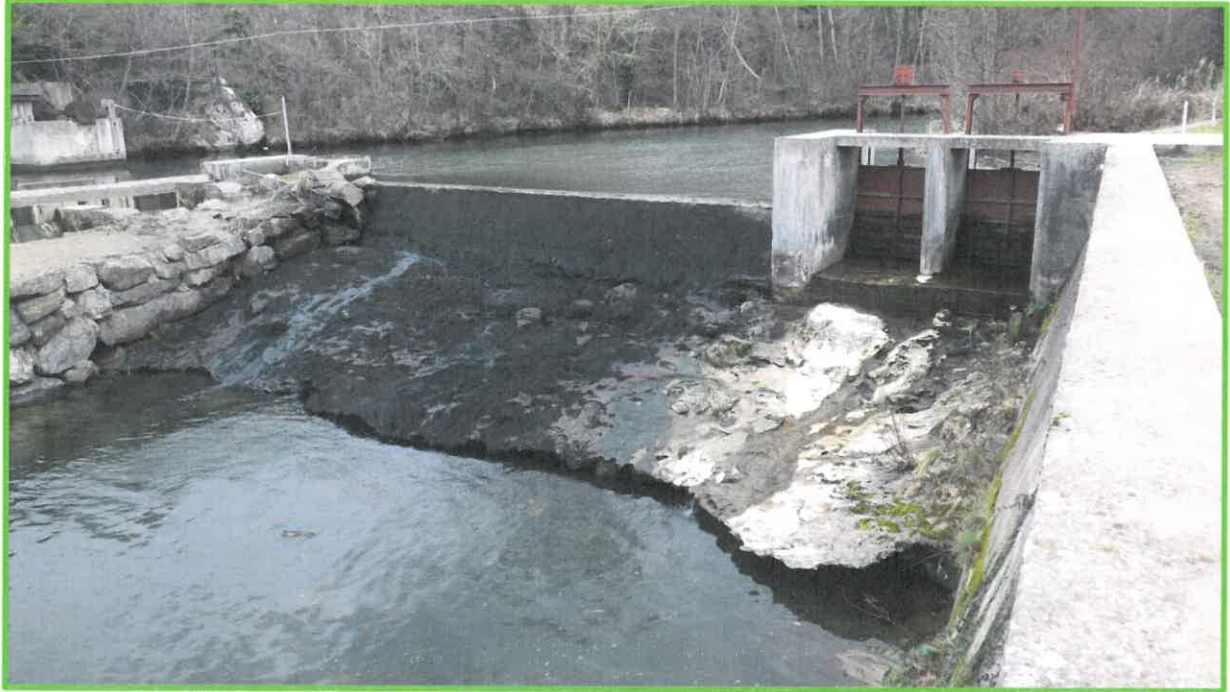
Photo 3 Vue du barrage depuis l'aval. Janvier 2015
