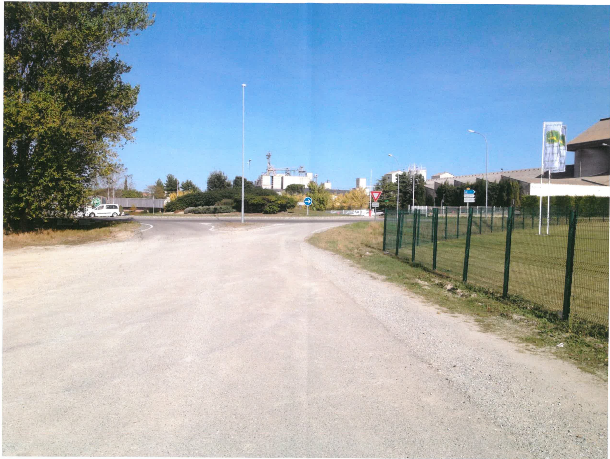
Photographie 12 : Vue en direction du giratoire « ARTERRIS »
