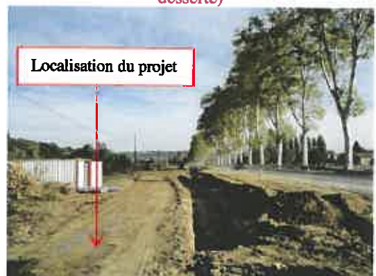
- Photo n°5 : Vue sur les travaux en cours du PRAE Charles Cros (Projet : Localisation du futur tracé de la nouvelle voie de desserte, à gauche des travaux)
