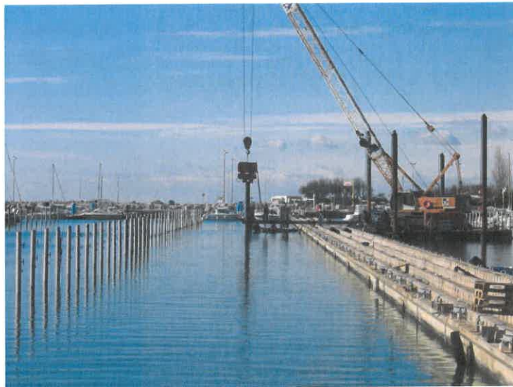
Photo 47 - grue sur ponton munie d'un appareil de vibro-fonçage
