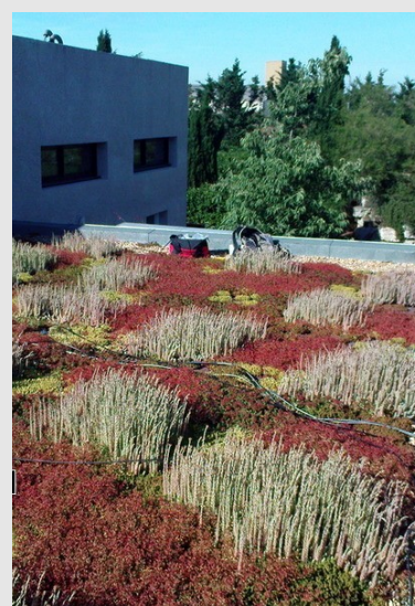
Terrasse végétalisée irriguée
